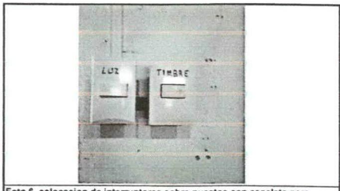
Foto 6. colocacion de interruptores sobre puestos con canaleta para proteccion del cable
