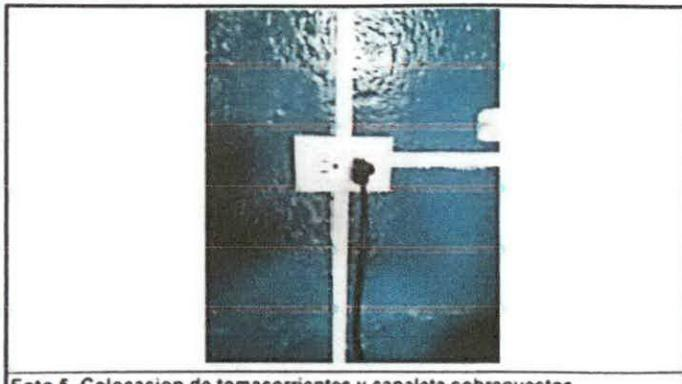
Foto 5. Colocacion de tomacorrientes y canaleta sobrepuestos
