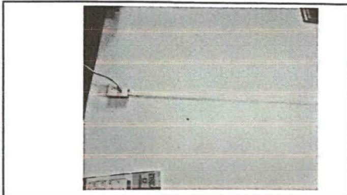
Foto 3. Colocacion de Canaleta para proteccion de cableado
